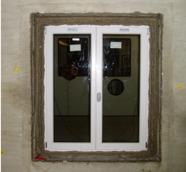
Bild 3 Foto des eingebauten Elementes, erstellt vom ift Schallschutzzentrum
